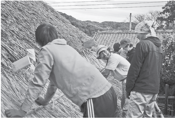
『古民家ゴンジロウ』屋根の葺替え作業
